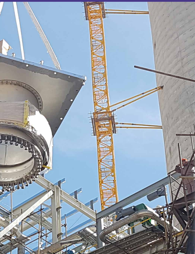
Abbildung: Einbau der GVSO in das Solarkraftwerk
